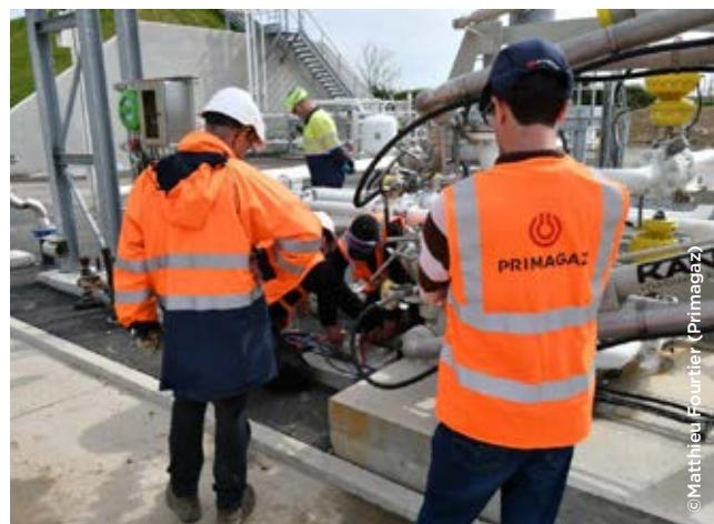
Chantier de Druye
