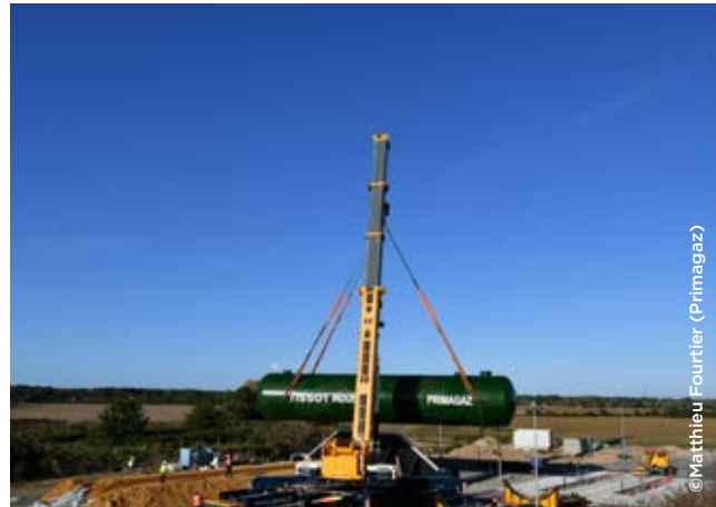
Chantier de Druye / mise en place du réservoir
